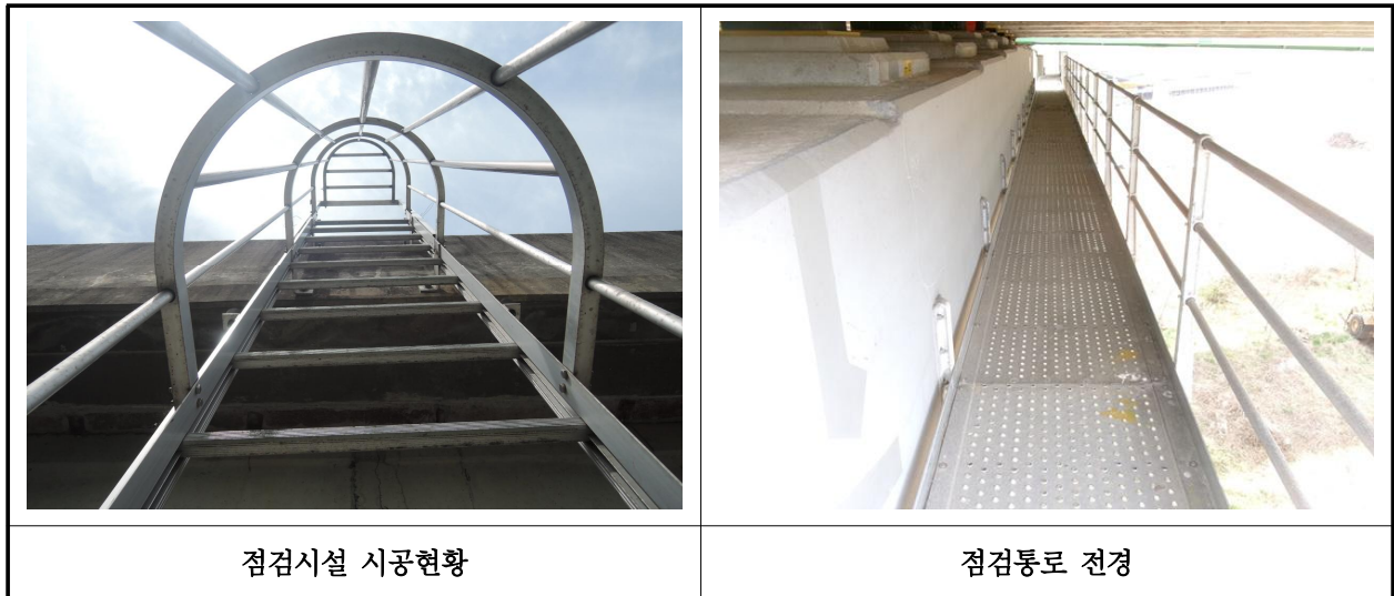
【사진 1.3.21】 교량 점검시설 전경
