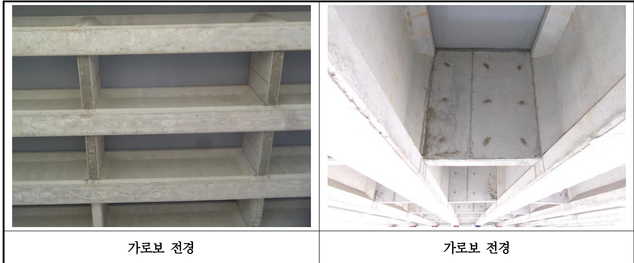
【사진 1.3.6】 가로보 전경
