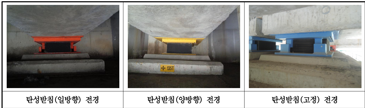
【사진 1.3.10】 교량받침 전경
