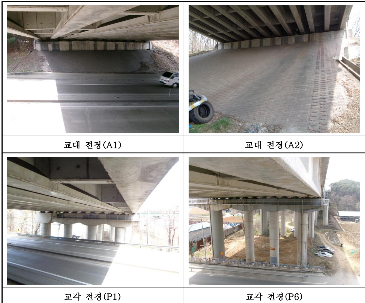
【사진 1.3.8】 교대 및 교각 전경
