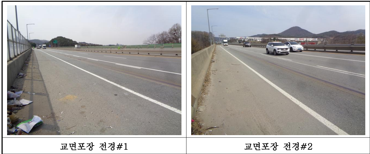
【사진 1.3.15】 교면포장 전경
