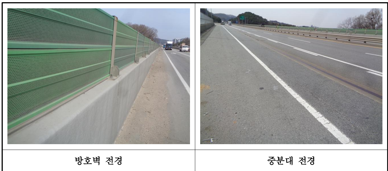
【사진 1.3.19】 난간 및 연석 전경
