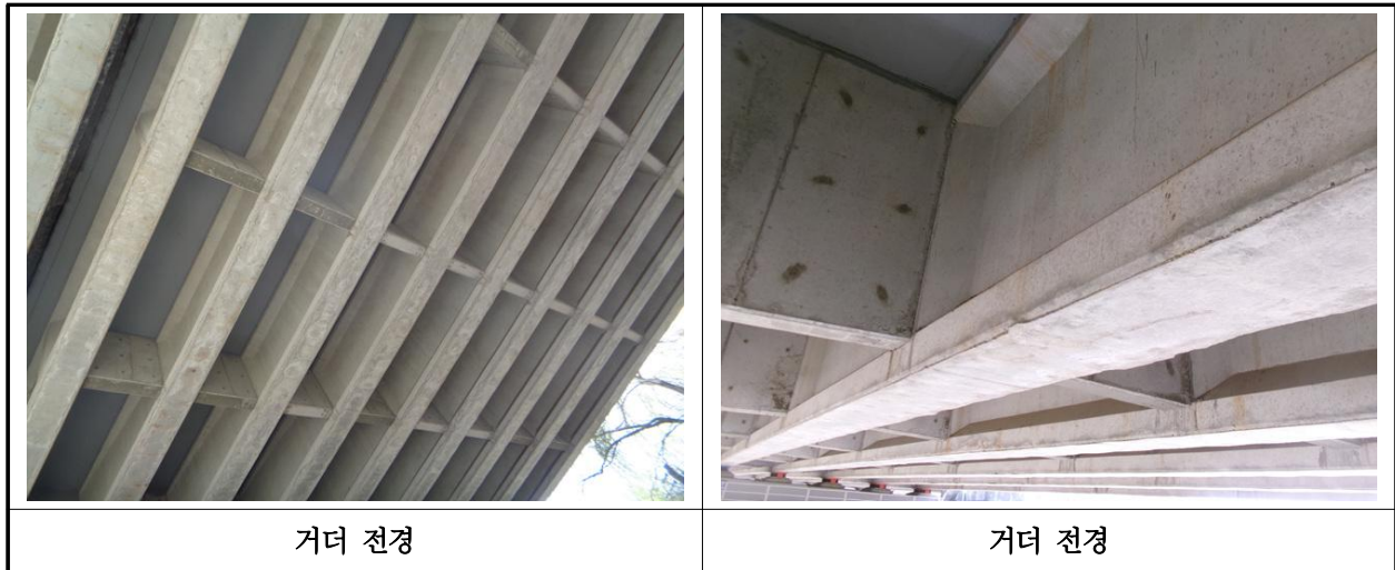
【사진 1.3.4】 거더 전경
