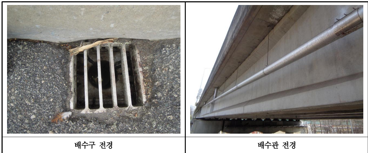
【사진 1.3.17】 배수시설 전경
