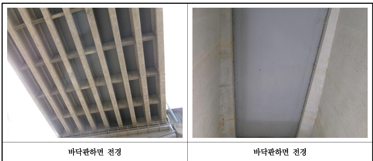
【사진 1.3.2】 바닥판하면 전경
